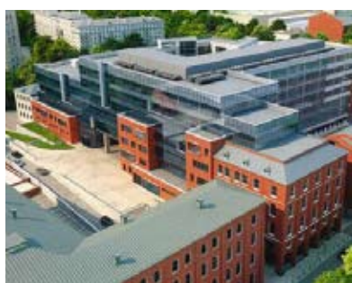
Офисный комплекс «Красная Роза», Тимура Фрунзе ул., 11, стр. 8
